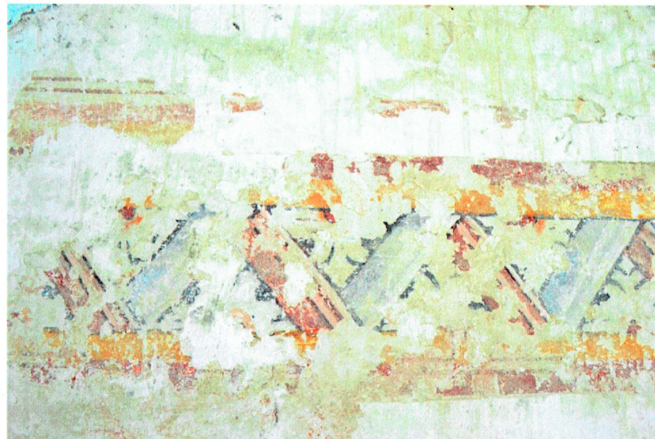
Vue rapprochée du sondage de la frise à triangle – 4 ème décor – Mur Sud - Nef
