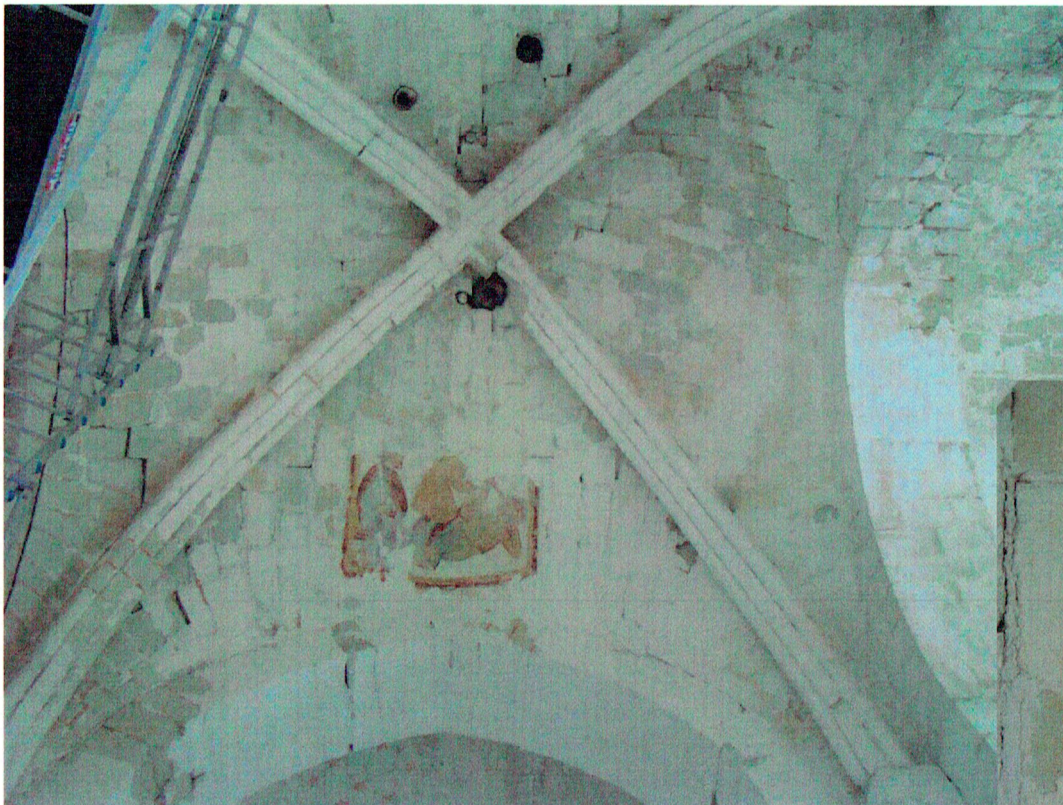
Vue d'ensemble de la voûte
