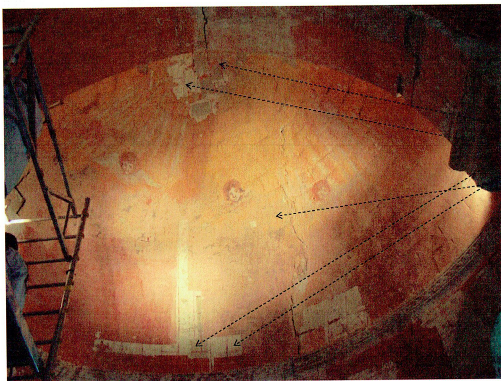
Vue d'ensemble de la voûte en cul de four de l'abside
