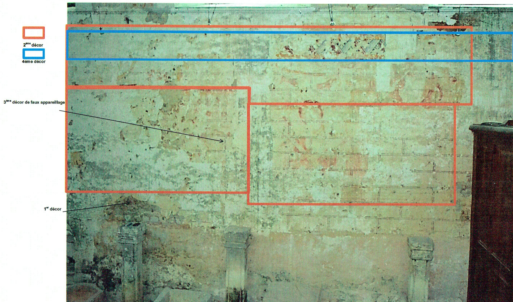
Vue d'ensemble des sondages et investigations en recherche de peintures murales et décors peints sur le mur Sud de la nef.
