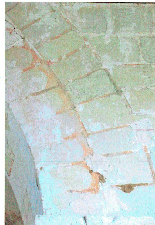
Vue rapprochée du décor peint 13 ème s. de l'arc d'entrée vers le transept Noter le décor peint impressionnant de double faux-appareillage autour de l'arc Noter également le décor peint d'appareillage simple sur le mur
