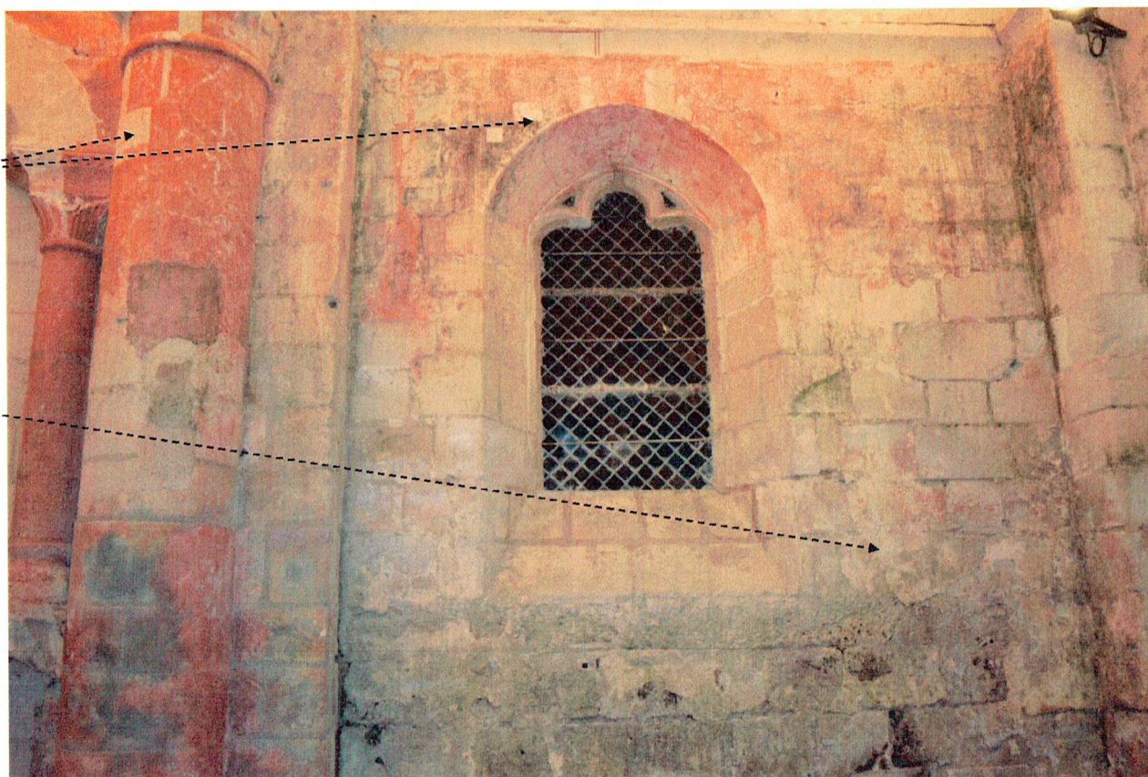
Avant-chœur – Vue d'ensemble du mur Sud
