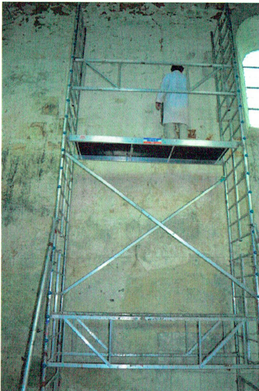
Fenêtre murée : Vue de l'échafaudage et situation du sondage
